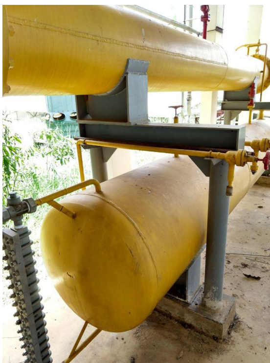
Figura 5 – Reservatório de amônia
